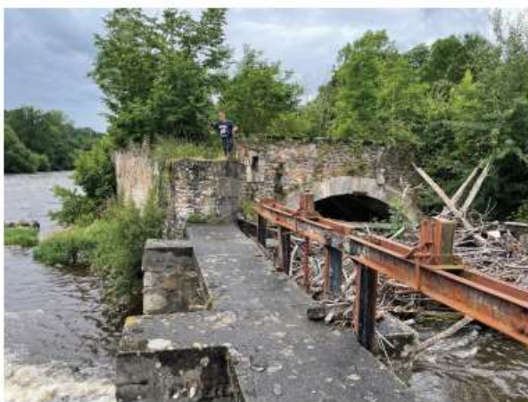
Photo 6 : Vannage de fond et prise d'eau voûtée au droit de l'extension = 1890 (côté amont)
